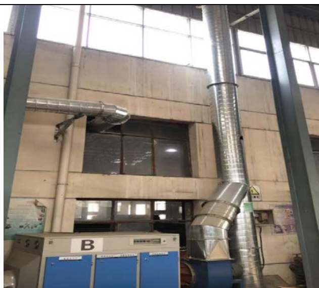
1号厂房印刷机排气筒（P2）及标识
