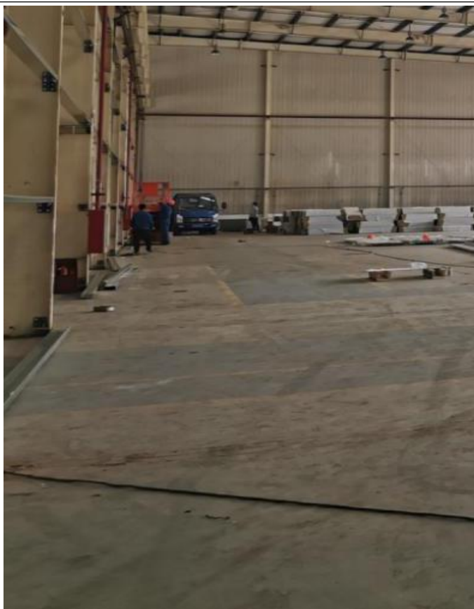
图 2 厂房现状照片
